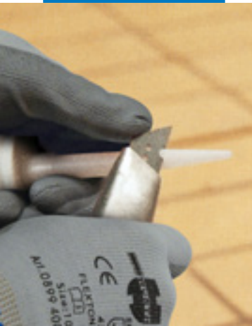
按接缝大小而定， 裁切密封胶管口
