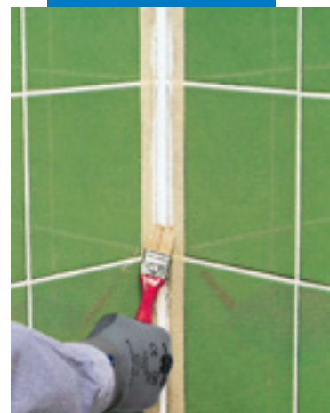
用小毛刷将肥皂水 抚平接缝
