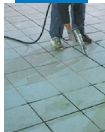
马贝硅酮密封胶AC 对瓷砖地面填缝
